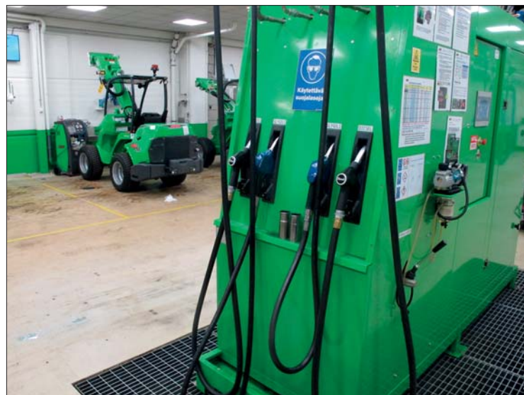
Na konci linky se do nakladačů načerpají provozní kapaliny. Nejprve se testují v klidu, poté v plném nasazení
